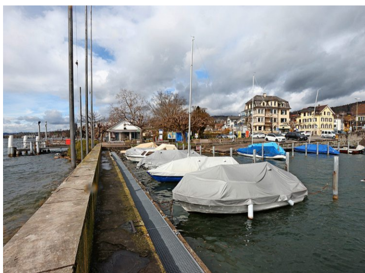
Der Hafen soll künftig freundlicher daherkommen. Foto: Sabine Rock
