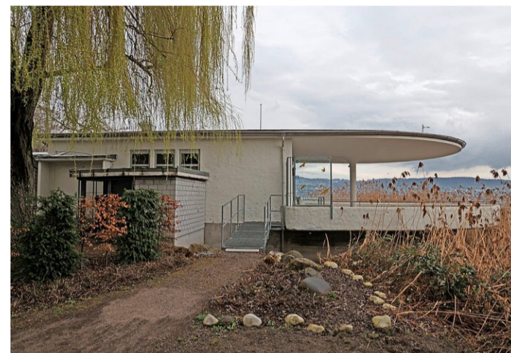
Das Strandbad Rietliau wurde in den 30er-Jahren gebaut und im Jahr 1990 zuletzt saniert. Fotos: Sabine Rock
